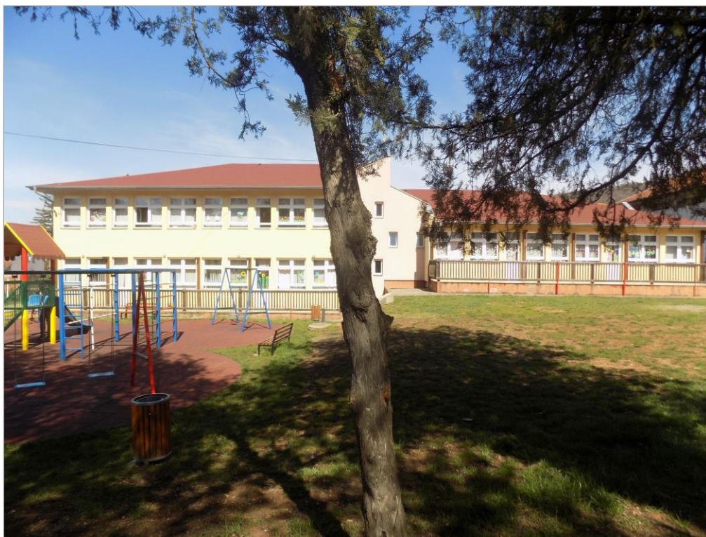
4а-Објект Предшколске установе Наша радост
